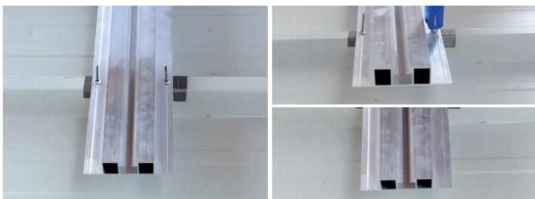
FASE 3 - Fissare il profilo con i rivetti STEP 3 - Fix the profile with rivets
