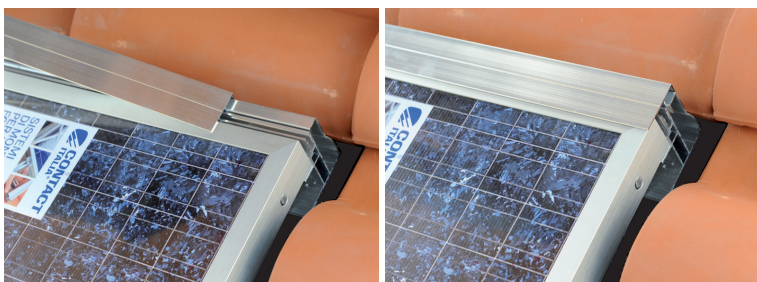
FASE 3 - Sovrapporre il profilo blocca pannelli
