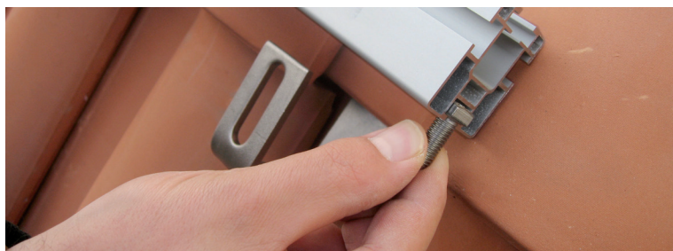
FASE 2 - Inserire le viti nella guida inferiore del profilo
