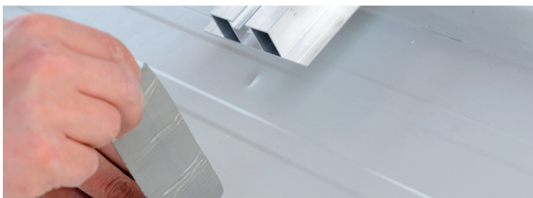
FASE 1 - Applicare il nastro butilico (VT0020) sulla lamiera grecata STEP 1 - Fit the self-adhesive rubber bitumen (VT0020) on the corrugated sheet
