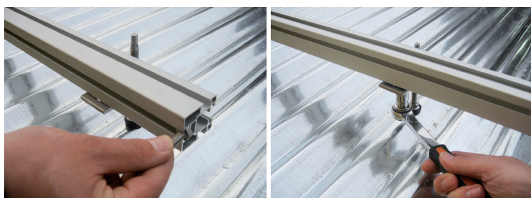
FASE 2 - Inserire le viti nella guida inferiore del profilo e fissare all'ancorante
