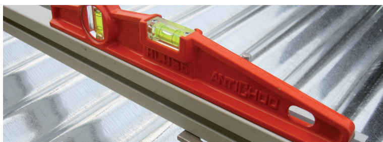
FASE 3 - Verificate l'allineamento
