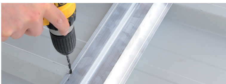
FASE 2 - Perforare la lamiera e il profilo STEP 2 - Drill the corrugated sheet and profile
