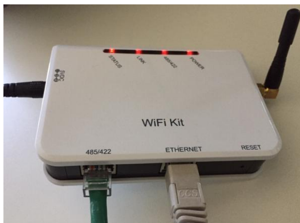
Figura 69 – Cavo ethernet connesso al datalogger
