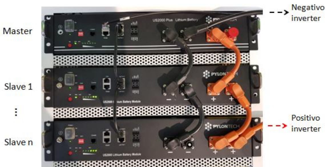
Figura 10 - Collegamento di tre batterie Pylontech in parallelo
