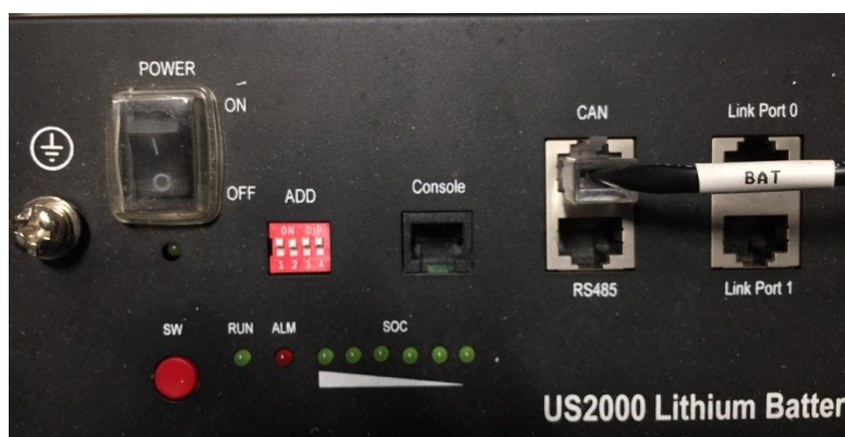
Figura 9 - Collegamento del cavo di comunicazione alla batteria Pylontech
