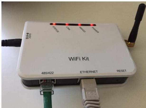
Figura 101 – Cavo Ethernet collegato al datalogger
