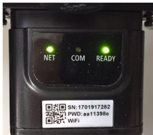
Figura 85 - Stato di comunicazione irregolare tra inverter e adattatore
