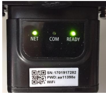
Figura 91 - Stato di comunicazione irregolare tra inverter e adattatore
