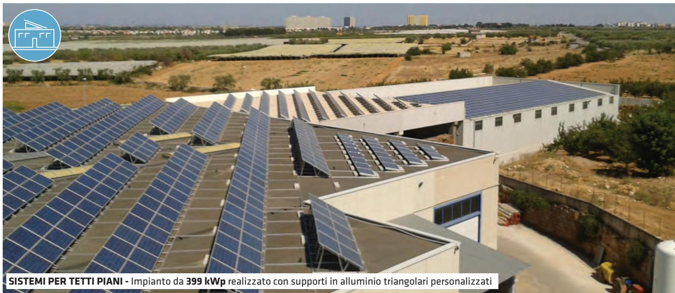
**SISTEMI PER TETTI PIANI** - Impianto da **399 kWp** realizzato con supporti in alluminio triangolari personalizzati
