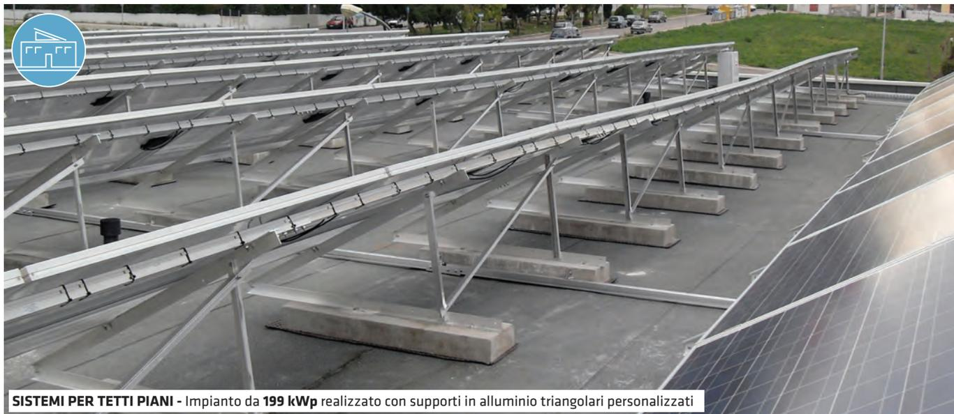
**SISTEMI PER TETTI PIANI** - Impianto da **199 kWp** realizzato con supporti in alluminio triangolari personalizzati
