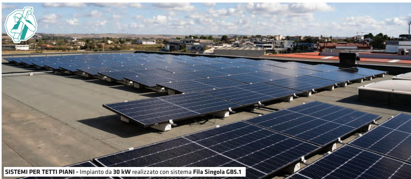
**SISTEMI PER TETTI PIANI** - Impianto da **30 kW** realizzato con sistema **Fila Singola GB5.1**
