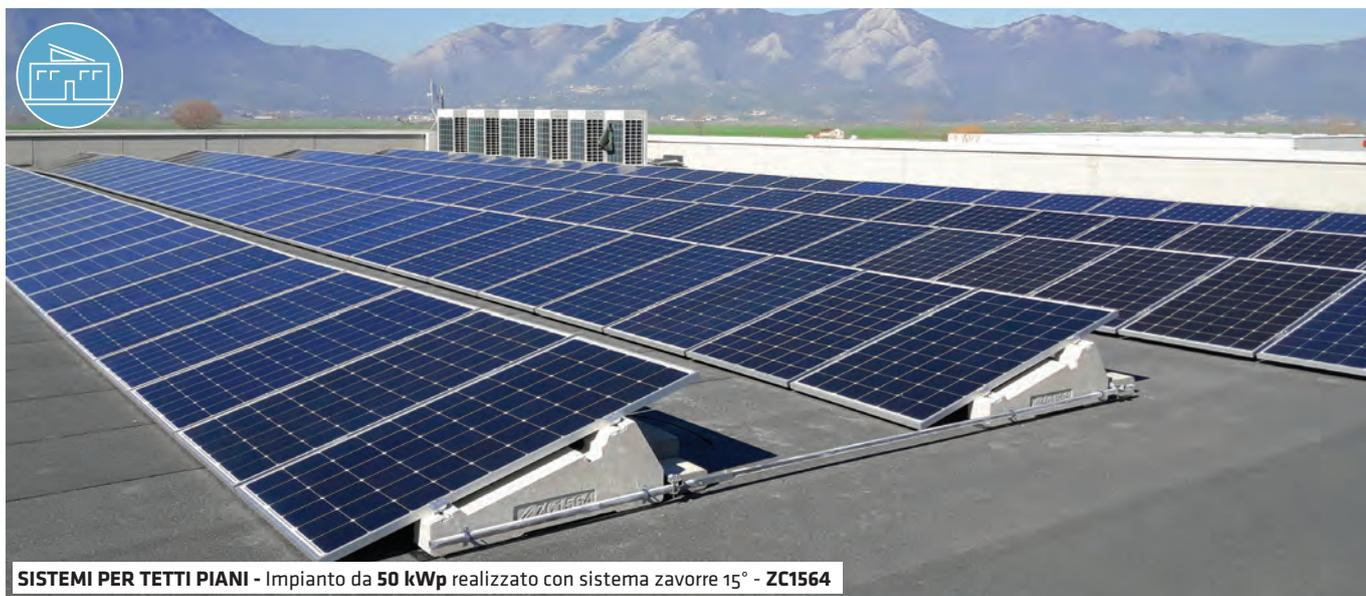
**SISTEMI PER TETTI PIANI** - Impianto da **50 kWp** realizzato con sistema zavorre 15° - **ZC1564**
