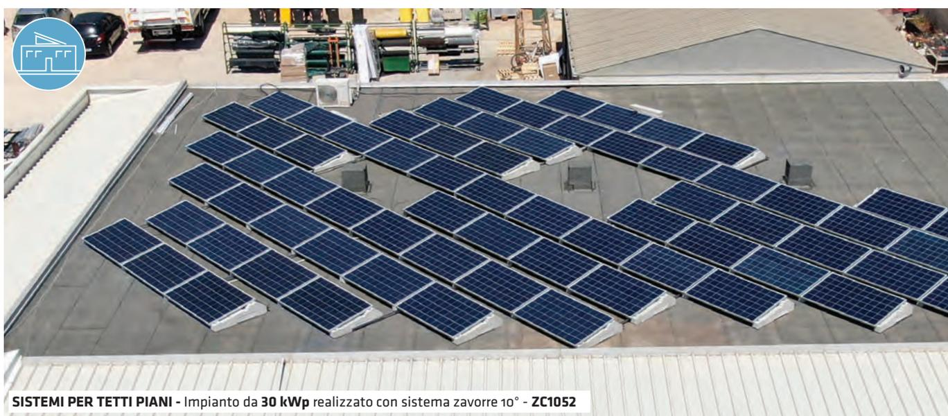
**SISTEMI PER TETTI PIANI** - Impianto da **30 kWp** realizzato con sistema zavorre 10° - **ZC1052**
