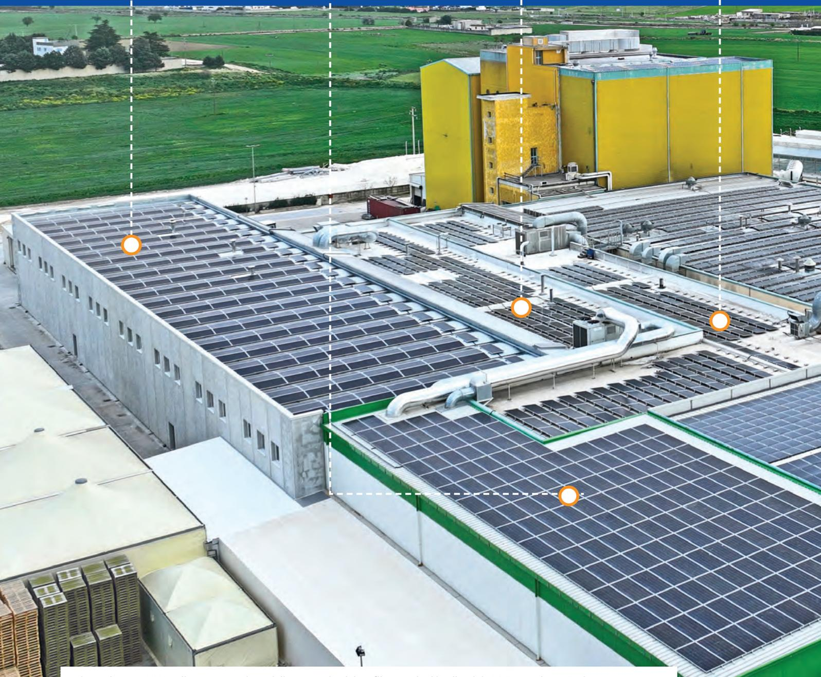
Impianto da **1,150 MW** realizzato con 8 sistemi di montaggio, dal profilo standard in alluminio PRT2785 al B-DUE, sistema con zavorre.
