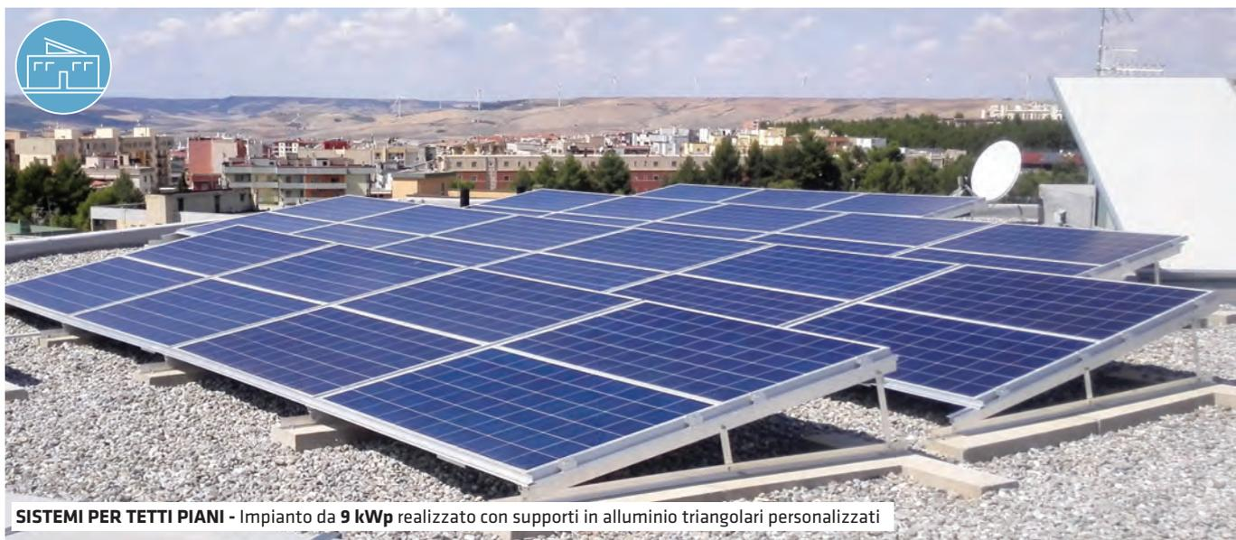
**SISTEMI PER TETTI PIANI** - Impianto da **9 kWp** realizzato con supporti in alluminio triangolari personalizzati
